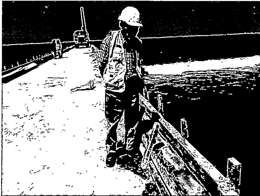
SUPERVISOR VERIFICANDO TRABAJOS
