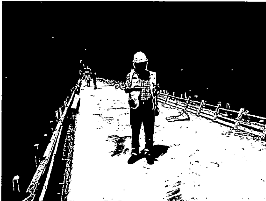
SUPERVISOR EN LOSA DEL MUELLE EJE- 163-164
